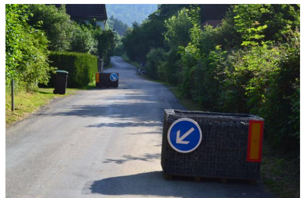
Installation de gabions, comme ici aux Hauts-Fourneaux
